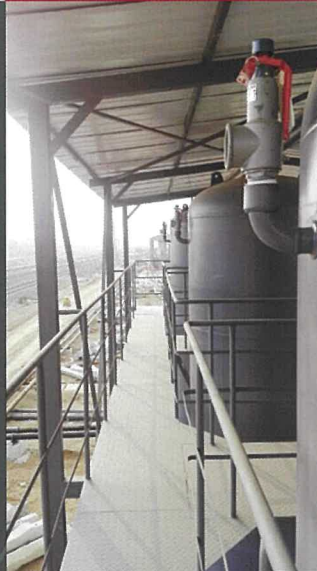
案例二： 上海铁路局合肥电务段 压力容器及压力管道 改造工程
